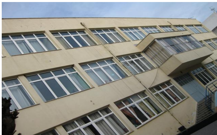
Πίνακας 7: Η πρόσοψη του σχολείου
